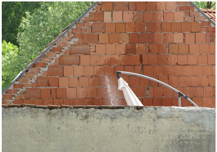
Bild 1: Wässern der Giebelwand des Praxisgebäudes mit Schlauch
